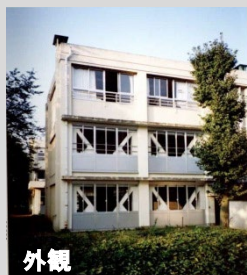
市立小学校(在来鉄骨枠ブレース)
